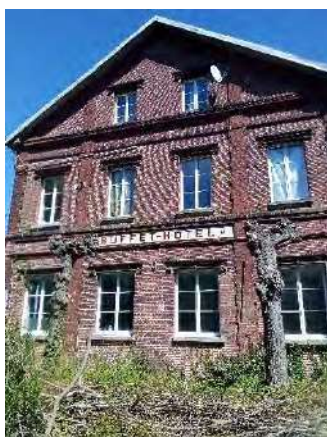
Réhabilitation de l'ancien buffet de la gare en logement
