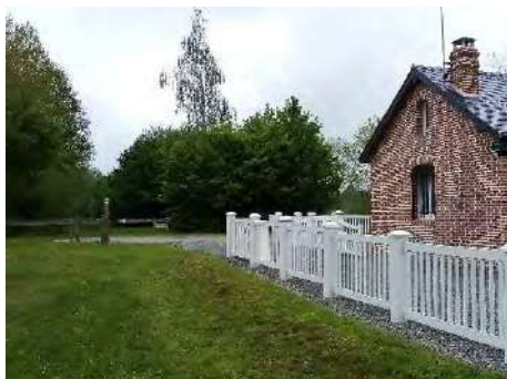
Maison de garde barrière réhabilitée
