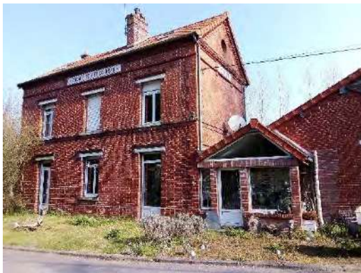
Ancienne gare de Proisy
