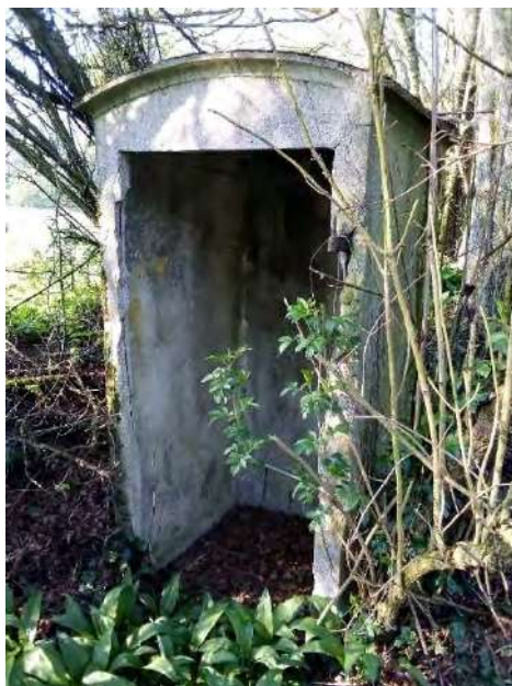
Ancienne cabine de voie ferrée
