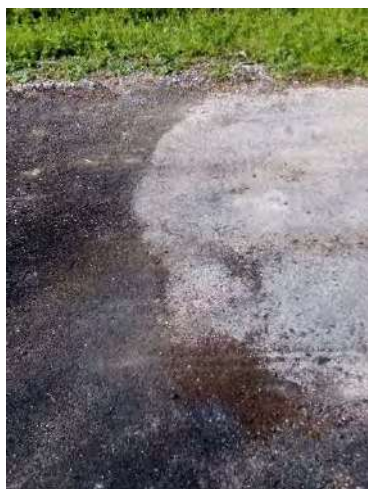
Démarcation ancien et nouveau macadam
