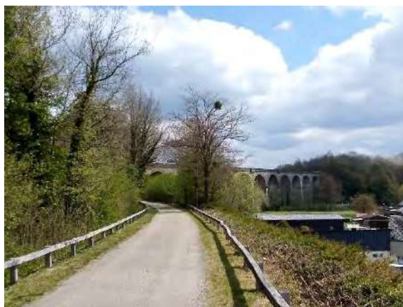
Vue sur le viaduc d'Ohis depuis l'EV3
