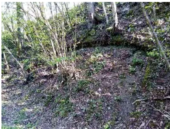
Vestiges d'un pont ferroviaire
